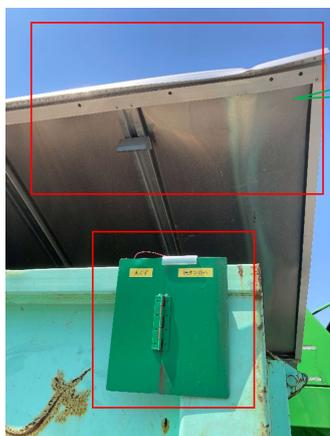
木くず専用産廃コンテナに屋根を取り付けました。(脱着式)
